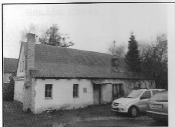
SNÍMEK Č. 1 – RD Č.P. 398, K.Ú. HORNÍ LIBINA
