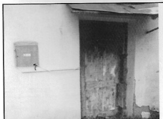
SNÍMEK Č. 5 – RD Č.P. 398, K.Ú. HORNÍ LIBINA
