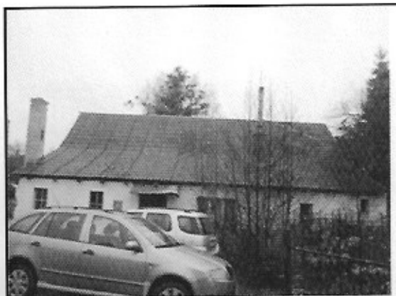
SNÍMEK Č. 2 – RD Č.P. 398, K.Ú. HORNÍ LIBINA
