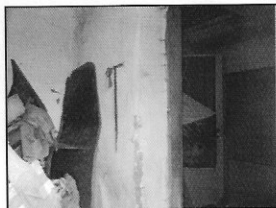
SNÍMEK Č. 6 – RD Č.P. 398, K.Ú. HORNÍ LIBINA
