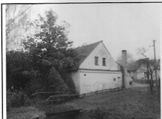
SNÍMEK Č. 3 – RD Č.P. 398, K.Ú. HORNÍ LIBINA
