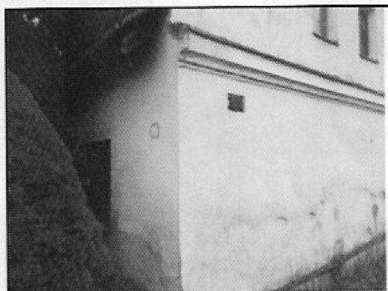
SNÍMEK Č. 4 – RD Č.P. 398, K.Ú. HORNÍ LIBINA
