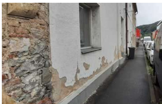
Spodní část fasády
