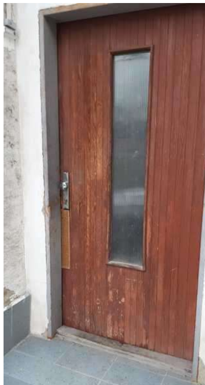
Vstupní dveře do domu
