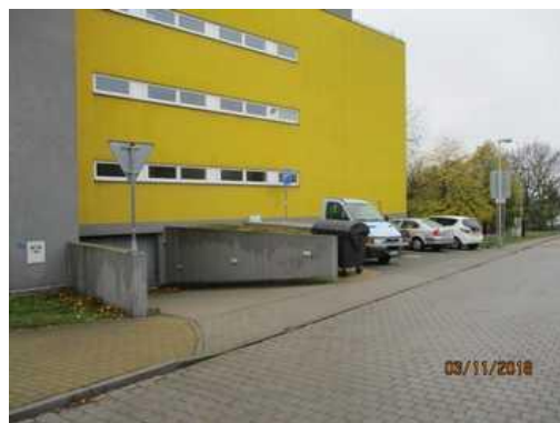
Vjezd do garáží a parkoviště z ulice Slatiňanské
