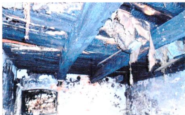
jedna ze stropních konstrukcí v objektu
