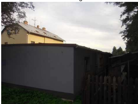
Boční pohled na řadové garáže
