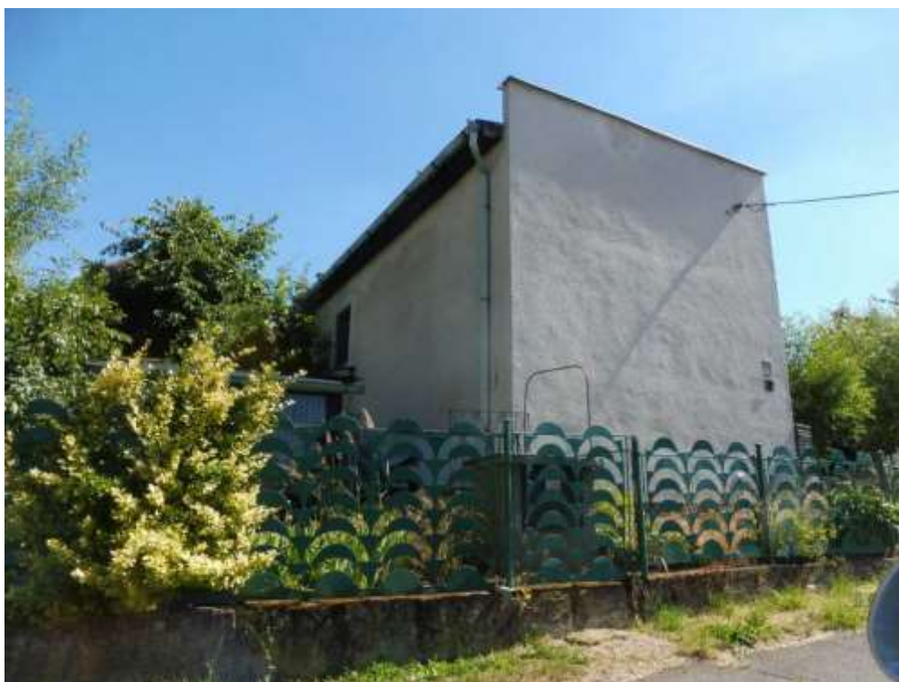
Pohled na dům č.p. 7 z příjezdové komunikace
