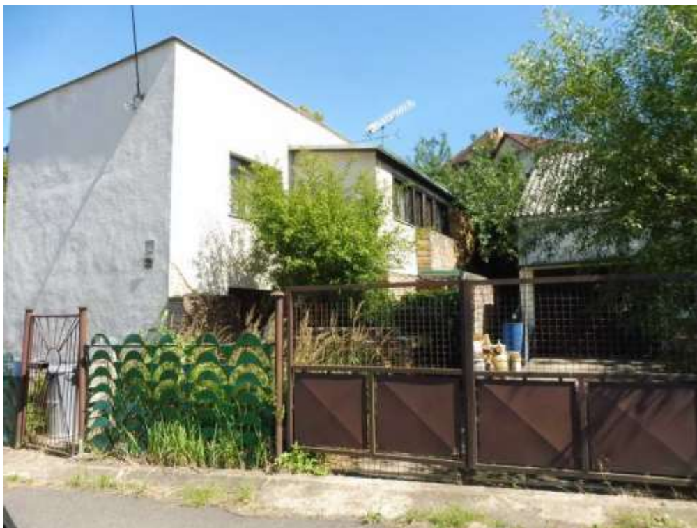
Pohled na dům č.p. 7 z příjezdové komunikace
