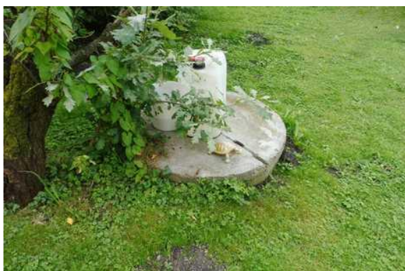
Studna – mimo provoz
