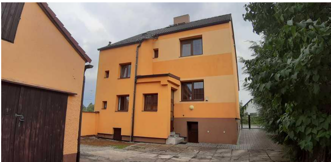
Pohled na dům zedvora
