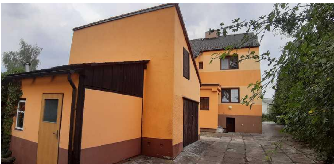
Pohled na dům ze dvora + sklad1
