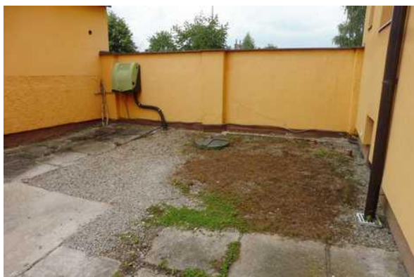
ČOV – v podzemí
