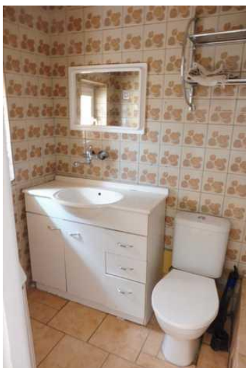
Byt 2+1 (2.NP) – Koupelna/WC
