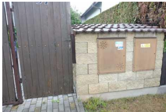
Přípojka plynu a elektro
