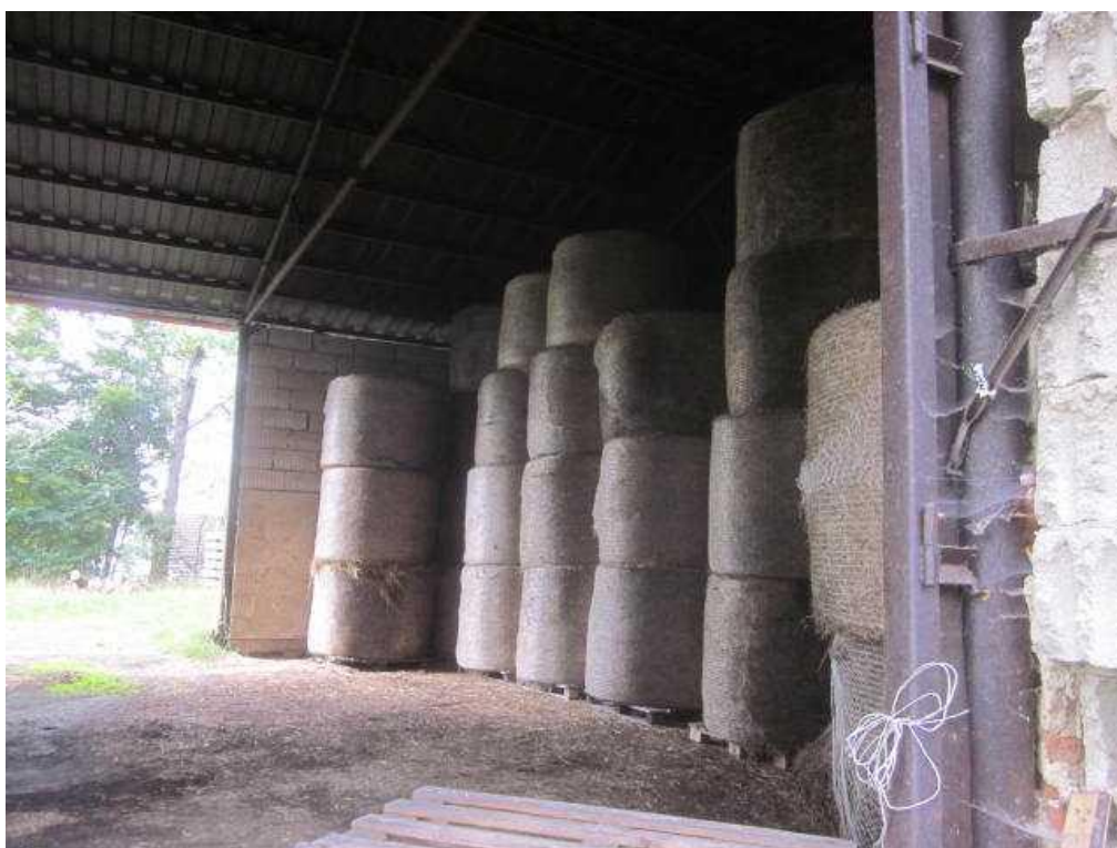
objekt skladu sena na st.p.č. 54/3 a st.p.č. 54/4
