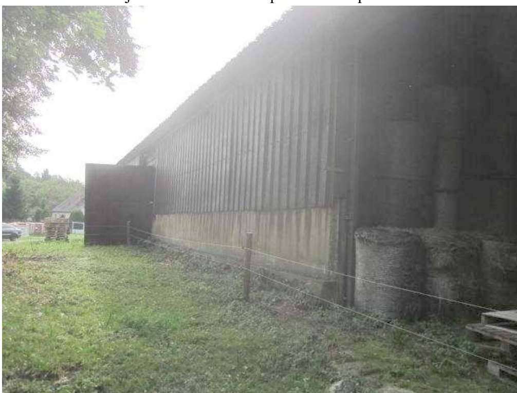
objekt skladu sena na st.p.č. 54/3 a st.p.č. 54/4
