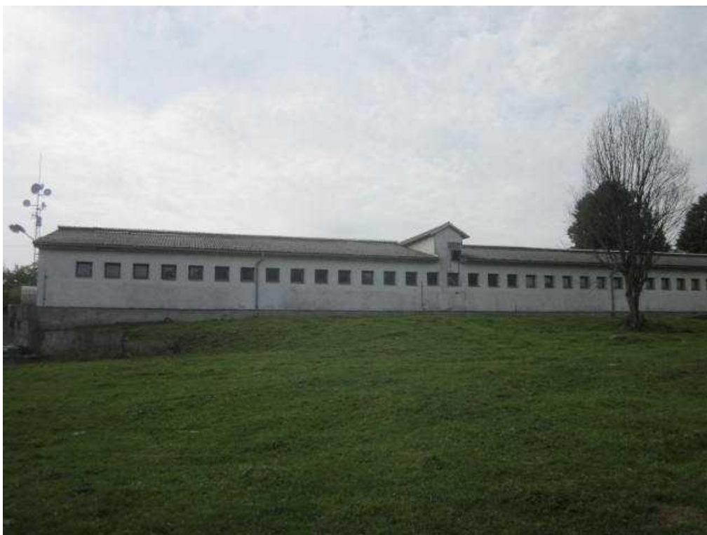
objekt prasečáku st.p.č. 47
