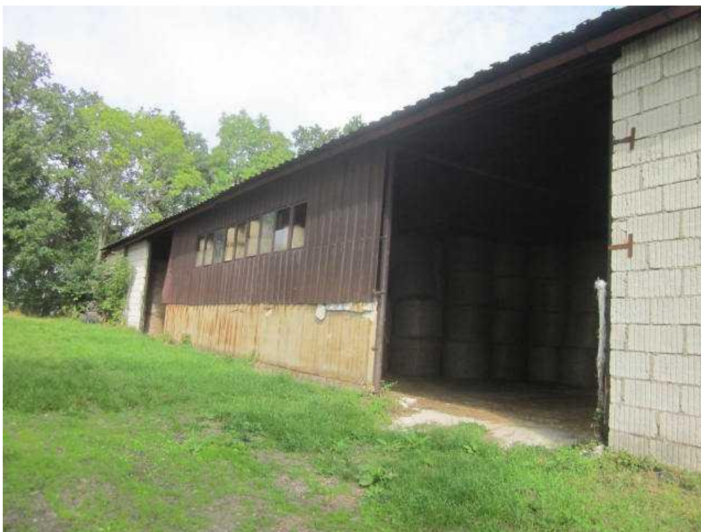
objekt skladu sena na st.p.č. 54/3 a st.p.č. 54/4
