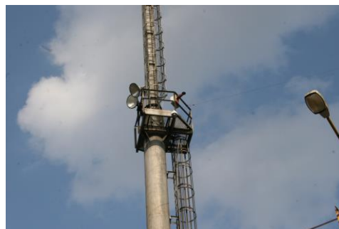
Kamerový systém / zabezpečovací zařízení
