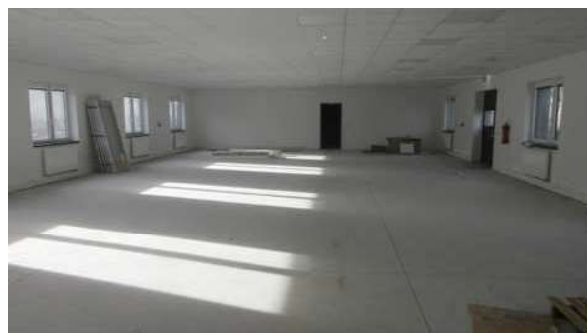
Provozní hala v 1.NP
