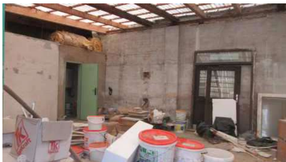
Interiér skladovací haly
