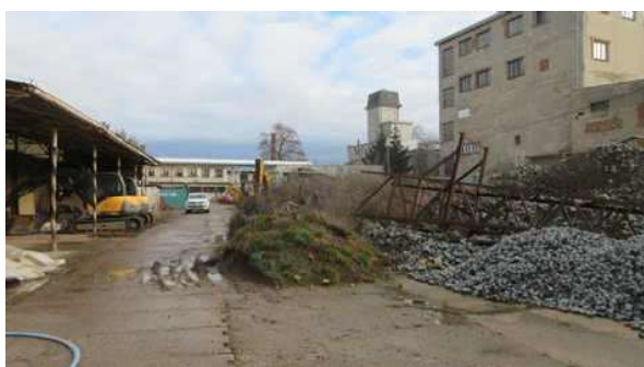
Zpevněné plochy areálu
