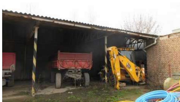
Přístřešek č. 2 na pozemku parc.č. st. 2824/1 v k.ú. Pražské Předměstí
