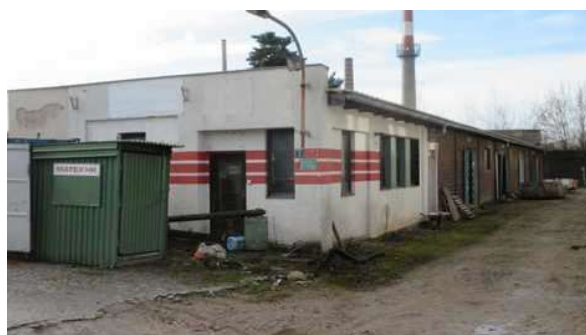
Skladovací hala bez č.p./č.e. na pozemku parc.č. st. 2824/1 v k.ú. Pražské Předměstí
