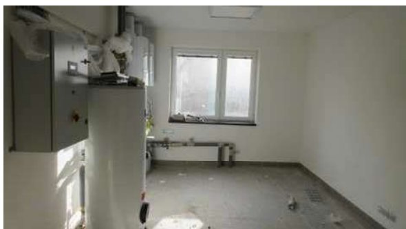
Technická místnost v 1.NP
