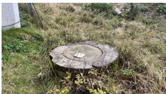
Stará nefunkční studna bez vody
