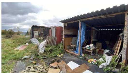
Různé přístřešky ve špatném stavu
