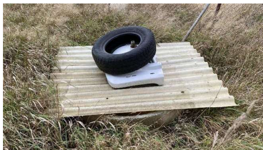
Nově vyhloubená studna
