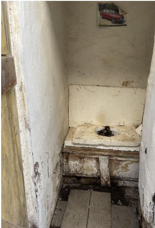
suché WC mimo obytné prostory (vstup z venku)
