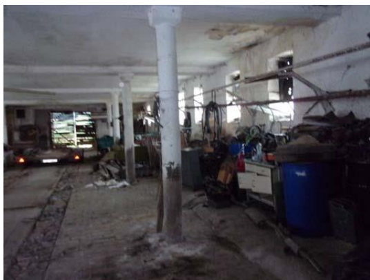
Hala, detail na sloup a průvlaky, podlahu, kde jsou do původního žlabu naskládány cihly, aby se podlaha výškově vyrovnala
