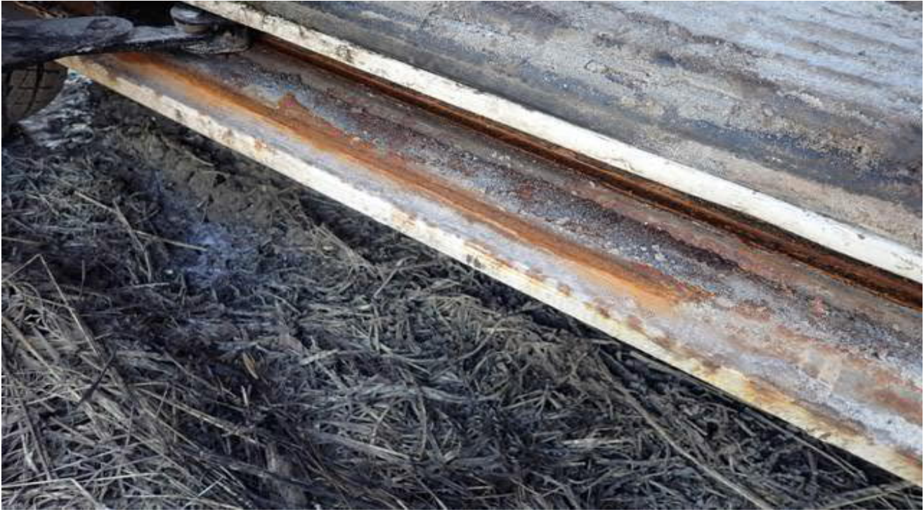
pravý práh zkorodován
