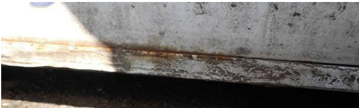
pravý práh zkorodován
