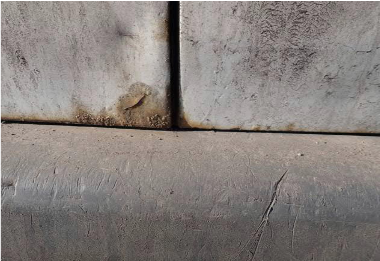
obě části zadních dveří zkorodovány
