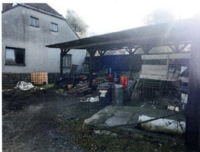
Pohled na provozní budovy farmy
