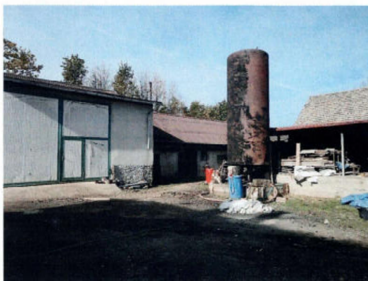
Pohled na provozní budovy farmy
