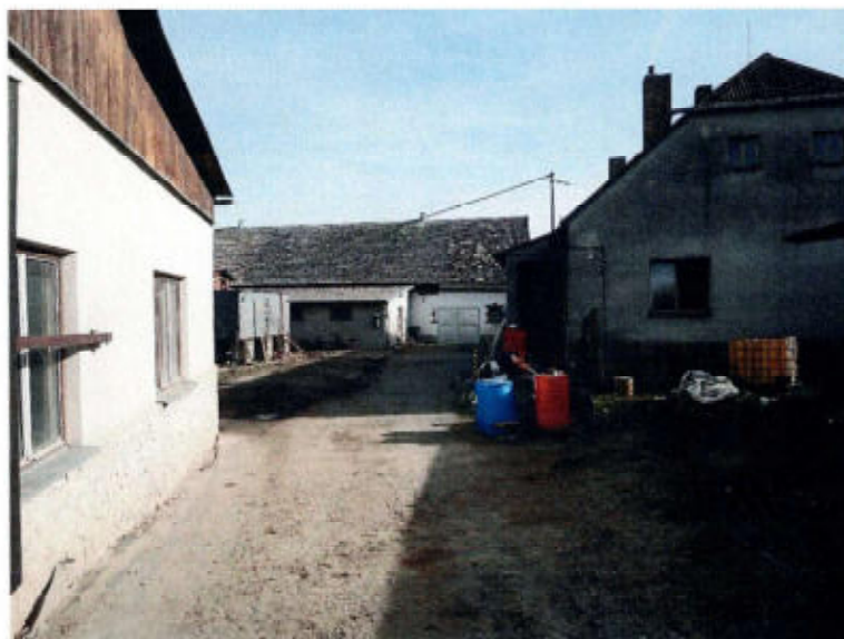
Pohled na provozní budovy farmy
