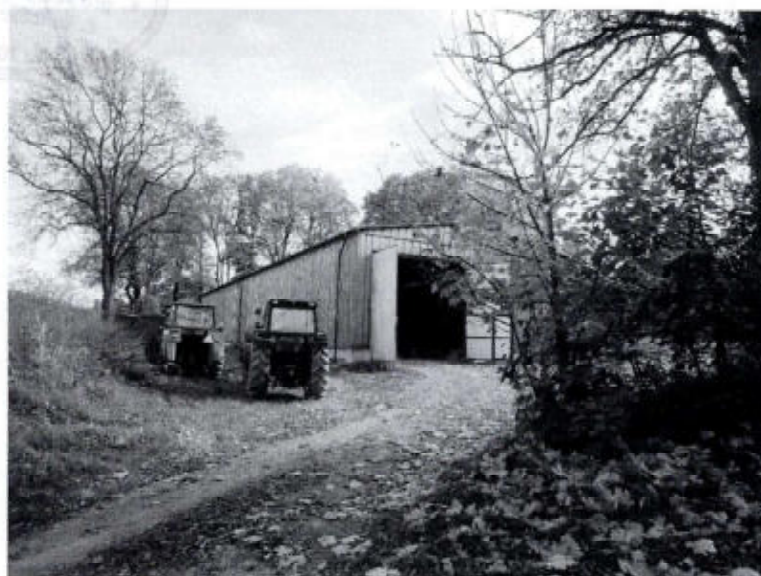
Hala k uložení strojů a zásob
