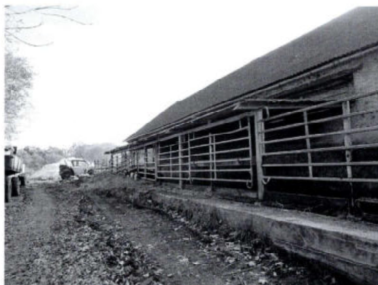
Pohled na provozní budovy farmy
