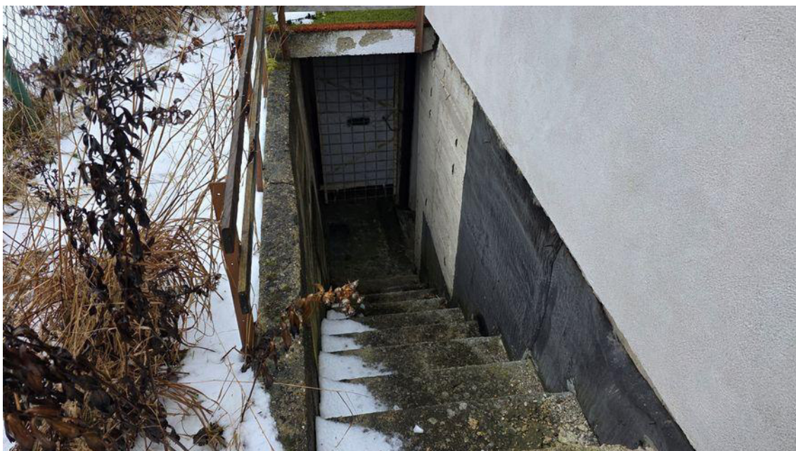
1.PP - Pohled na schodiště do sklepa
