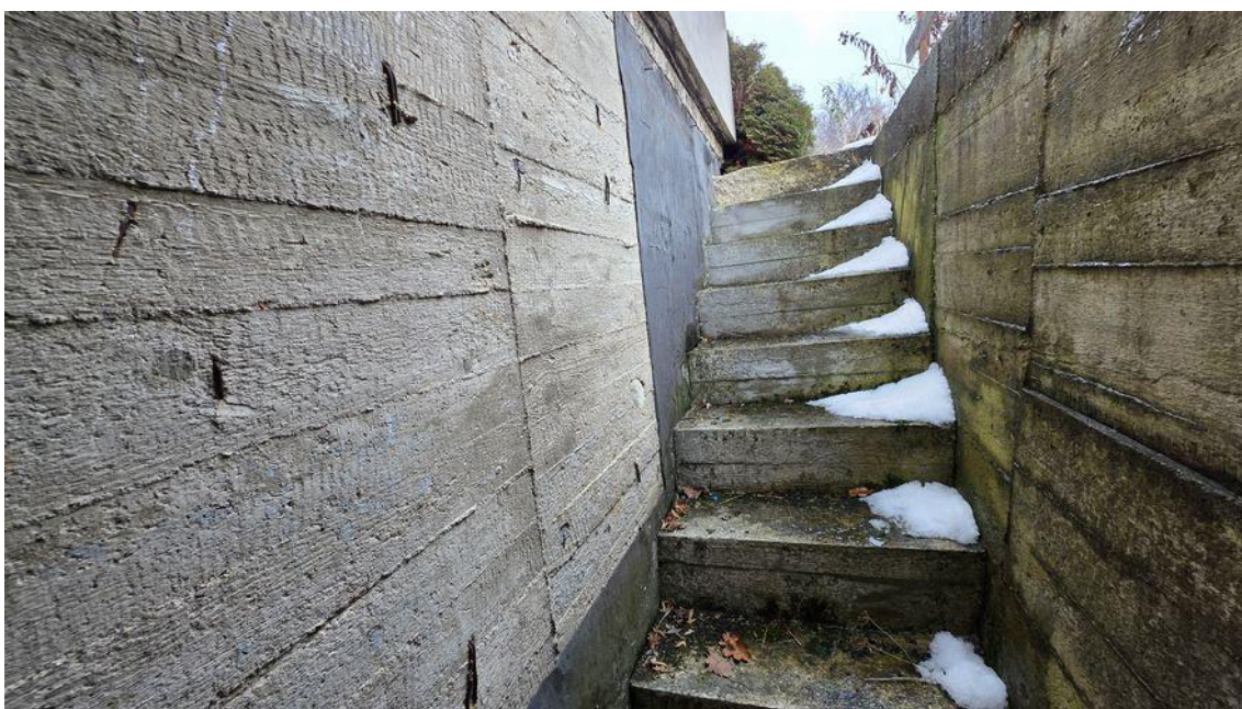
1.PP - Pohled na schodiště do sklepa
