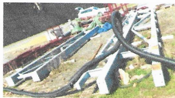
Obr. č. 1. Pohled na demontované rámy Pochozích lávek
